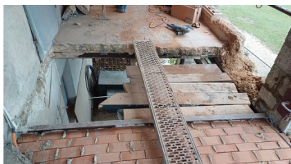
Terrasse pendant les travaux...
