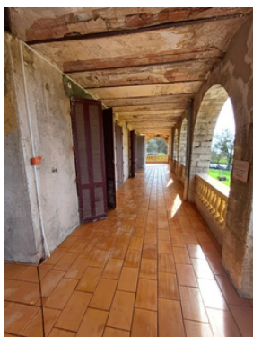
... et après les travaux.
